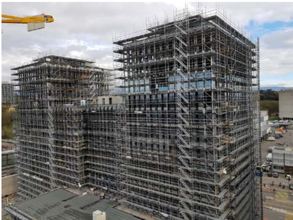
Image 1: Chantier en cours – copyright Alpiq
