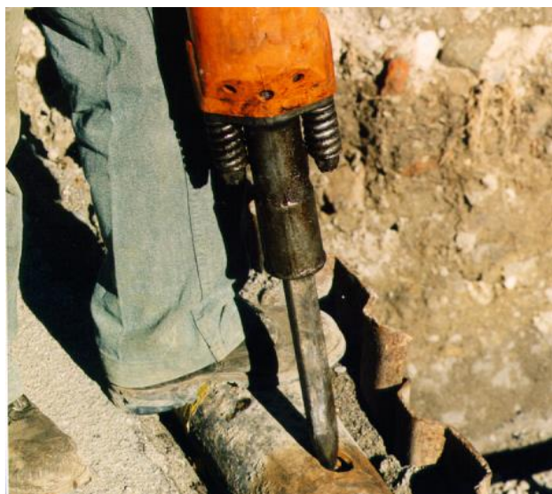
Durchbohrte Stahlleitung
